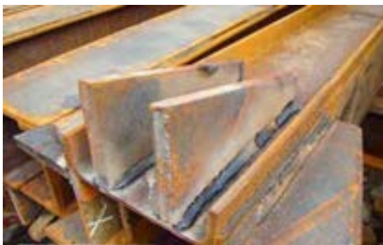
ب) شکل ۳-۱۹ اتصال سازه فلزی جوش کاری
