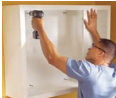
شکل ۲۳-۵ - پیچ و رولپلاگ
