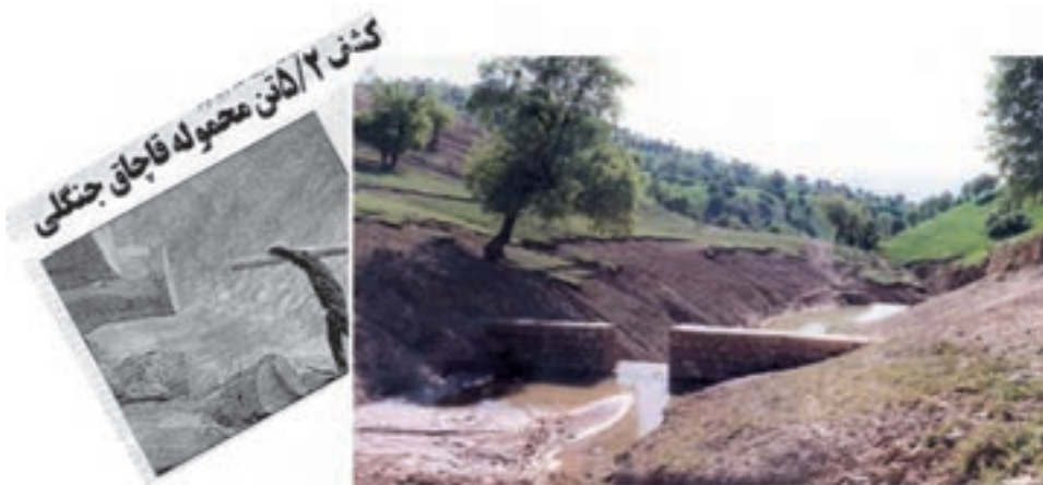
تصویر ۴-۱۵- اجرای طرح‌های آبخیزداری جهت کنترل سیلاب
