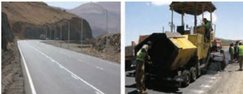
شکل ۵-۶- بخشی از فعالیت های راه سازی در استان
