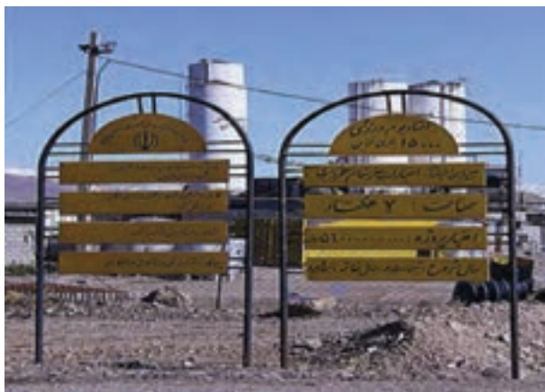
شکل ۱۰-۶- ورزشگاه ۱۵۰۰۰ نفری قزوین در حال ساخت
