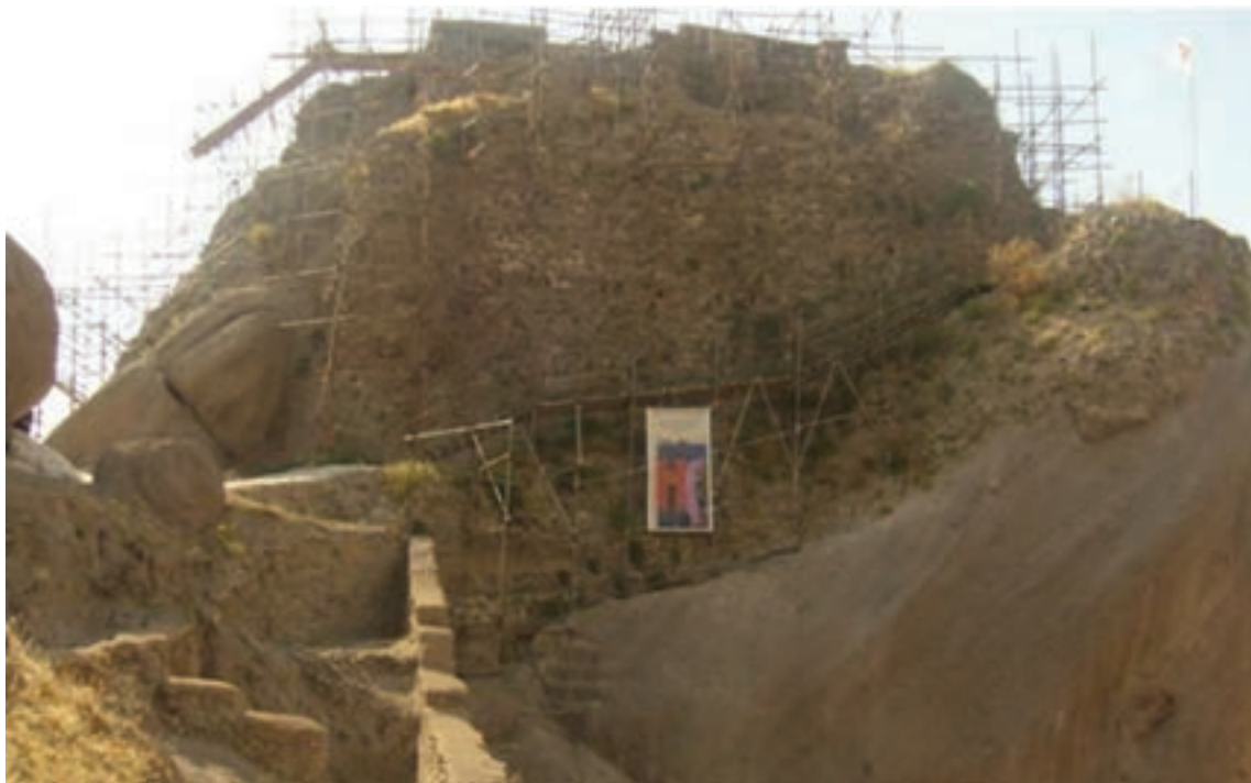
شکل ۲-۴- قلعه حسن صباح الموت، در حال مرمت
