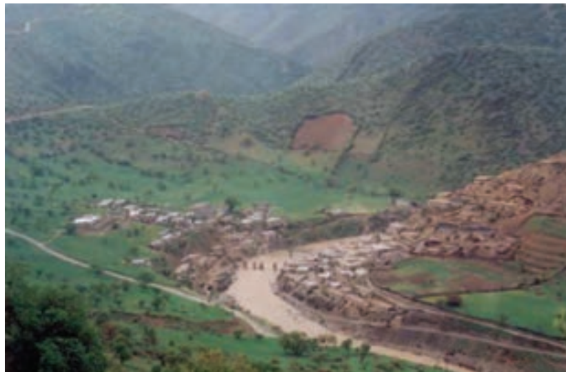
شکل ۳۸-۱- عدم رعایت حریم رودخانه و خطر سیل
