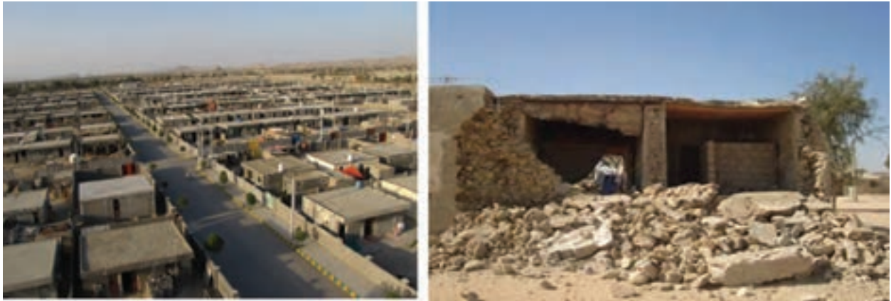
شکل ۶۰-۱- زلزله در شهرستان قشم
