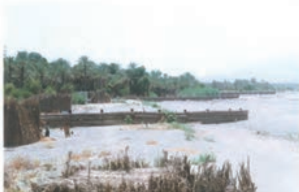
اپی‌های احداث شده با هدف حفاظت کناره‌ها
