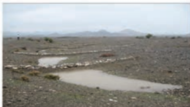
عملیات آبخیزداری احداث بندهای خشکه‌چین شکل ۵۹-۱- مجموعه عملیات آبخیزداری
