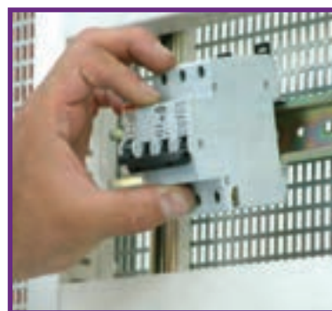
طرز قرارگیری فیوز روی ریل
