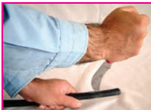
شکل ۳-۴- طریقه صحیح روکش برداری کابل
