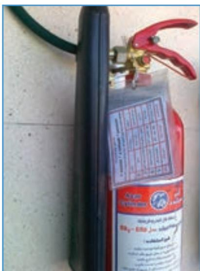
شکل ۱۰—پلاک مشخصات و تاریخ شارژ نصب شده روی کپسول
