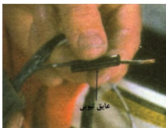
شکل ۶۳-۶- وارد کردن سیم به داخل عایق تیوبی
