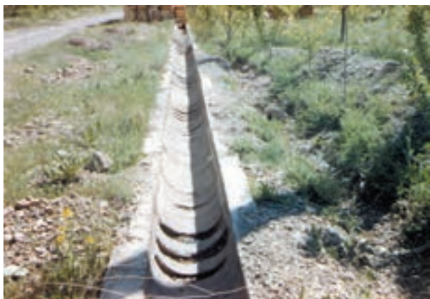
شکل ۲-۲- کانال با مقطع دوزنقه‌ای
