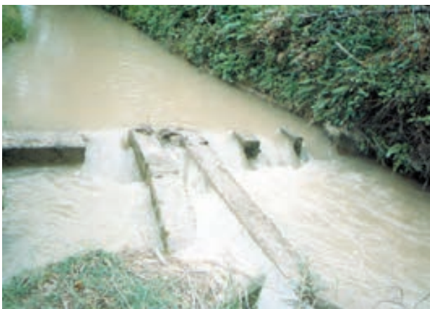
شکل ۸-۲ - مقسم ثابت
