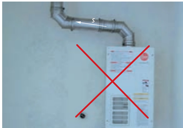
شکل ۱-۳۶ اتصال نادرست دودکش
