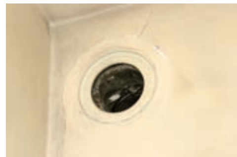
شکل ۱-۴ دودکش در محل نصب آب گرم کن.
