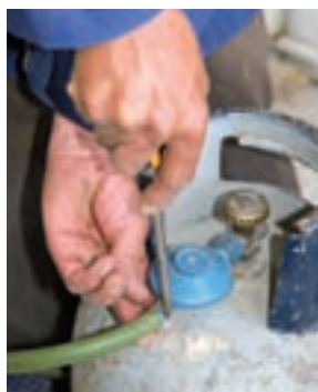
شکل ۱-۶۶ ب سفت کردن بست
