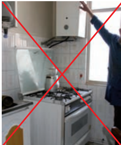
شکل ۱-۶ نصب نادرست آب گرم کن.
