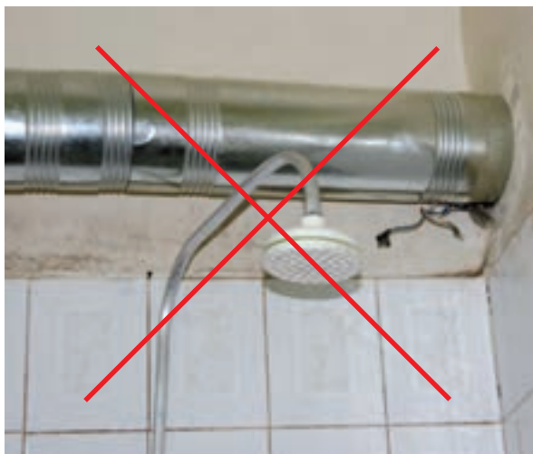
شکل ۳-۱۱ عبور غیر مجاز دودکش
