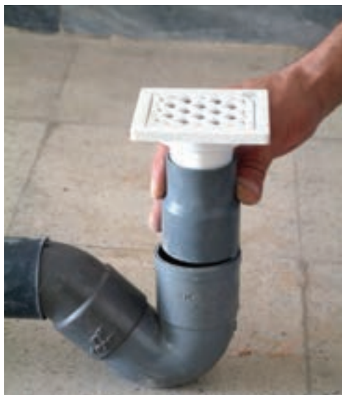
شکل ۳-۱۹- اتصال کف‌شوی به وسیله‌ی تبدیل
