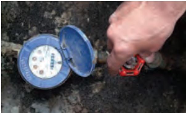
شکل ۱-۲۰۹ - بستن شیر فلکه‌ی اصلی ساختمان
