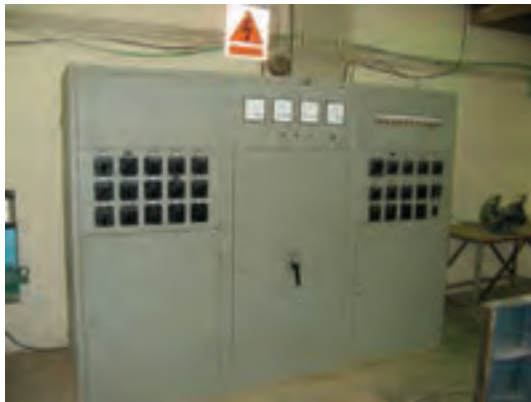
شکل ۱۴۹-۱۵. تابلوی اصلی برق ماشین‌آلات کارگاه صنایع چوب.
