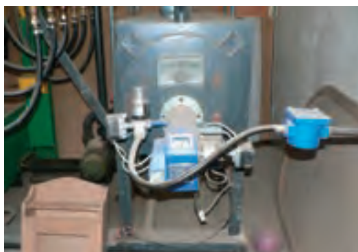
شکل ۱۳۰-۱۵. تجهیزات مشعل حرارتی (روی دیگ روغن پرس).
