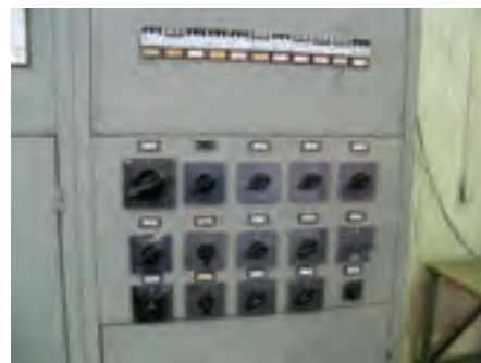
شکل ۴۰-۱۵- کلید اصلی پرس (دیف بالا سمت چپ در تابلوی ورودی برق).
