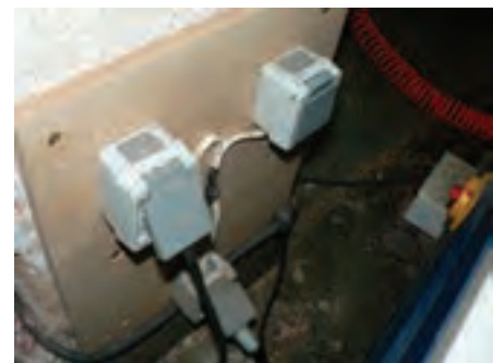
شکل ۲۱۳-۱۶- تابلو برق غیراستاندارد.
