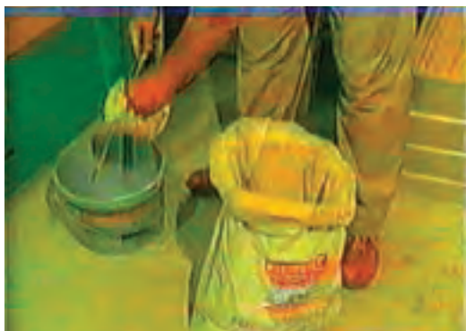
شکل ۶۰-۱۵- مل کردن پودر چسب در آب.
