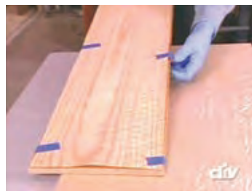
شکل ۱۲-۱۵- ثابت کردن روکش چسب زده شده روی صفحه با نوار چسب.
