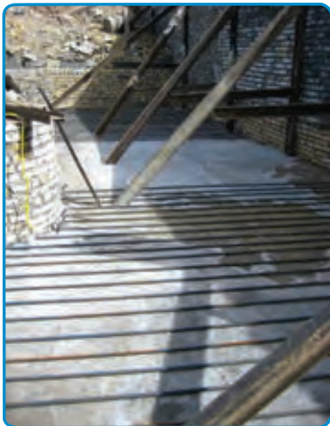
شکل ۳-۴۶- میلگرد طولی کف پی
