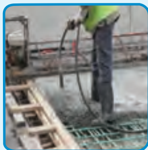
شکل ۱۴-۳- ویبراتور یا لرزاننده بتن داخل قالب
