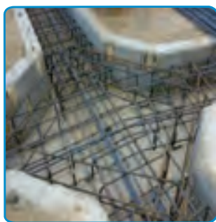
شکل ۱۴-۷- تکمیل میلگردگذاری محل اتصال ستون
