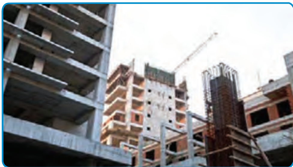
شکل ۱-۲- سازه‌های بتن آرمه
