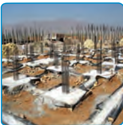
شکل ۱۷-۷- اجرای خاموت و سنجاقک
