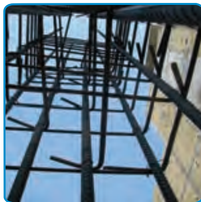
شکل ۱۹-۷- کار گذاشتن میلگردهای انتظار ستون، در فونداسیون
