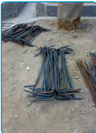
شکل ۷-۷- آماده کردن میلگردهای طولی و عرضی
