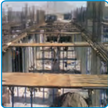
شکل ۷-۲۱- قالب بندی تیرها
