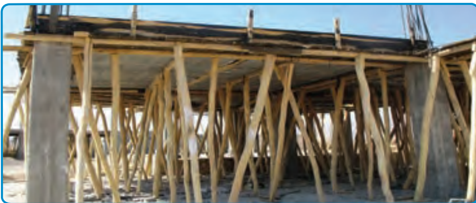
شکل ۳-۲۴- استفاده از شمع‌های چوبی جهت نگهداری قالب‌ها
