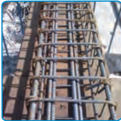
شکل ۷-۲۵- بستن خاموت ها با مفتول
