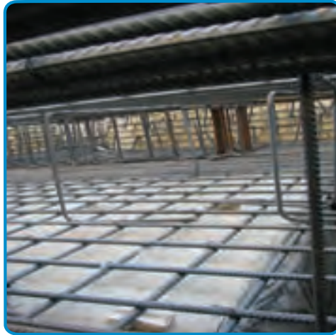
شکل ۳-۵۳ - استفاده از خرک در میلگرد گذاری پی
