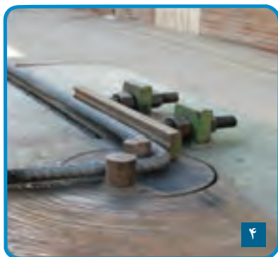
شکل ۳-۶۴- خم کردن میلگرد
