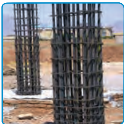
شکل ۱۶-۷- بتن ریزی ستون
