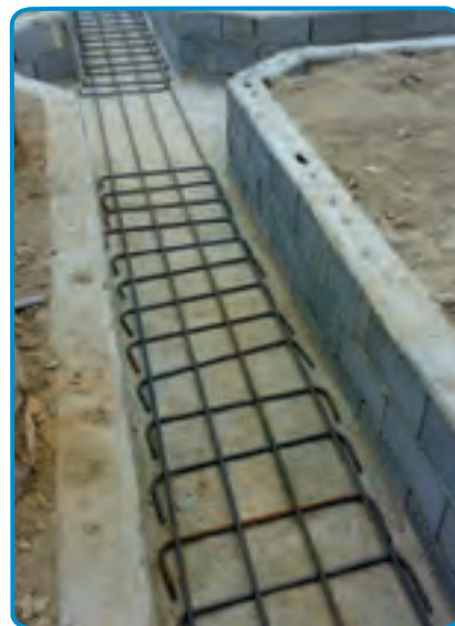
شکل ۸-۷- چیندن میلگردهای طولی و عرضی
