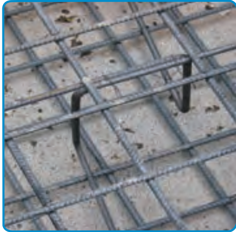
شکل ۳-۵۳ - استفاده از خرک در میلگرد گذاری پی
