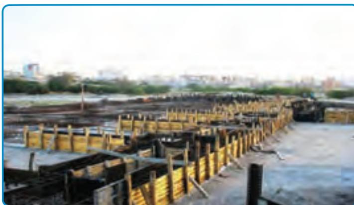
شکل ۳-۲۷- قالب چوبی برای اجرای پی
