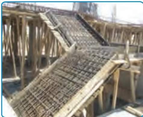
شکل ۳۹-۷- اجرای میلگردهای دال پله
