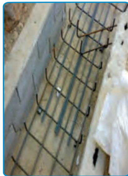
شکل ۱۱-۷- قرار دادن میلگردهای تقویتی
