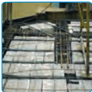
شکل ۳۲-۷-اجرای تیرهای فرعی کنسول
