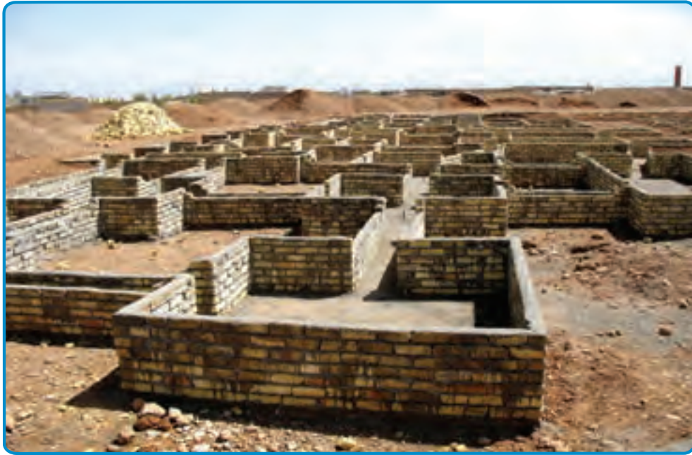
شکل ۱۵-۳- استفاده از قالب آجری برای اجرای پی
