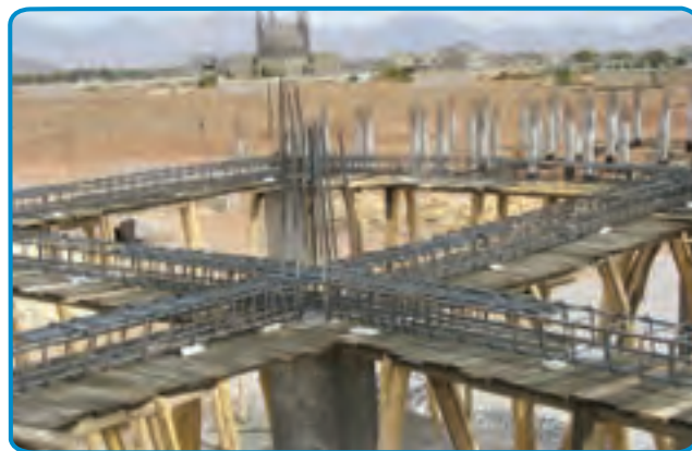
شکل ۷-۲۷- رعایت فاصله پوشش بتنی در کف
