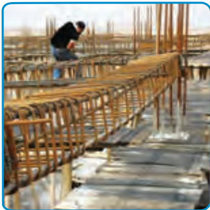
شکل ۷-۲۴- تنظیم فاصله بین خاموت ها
