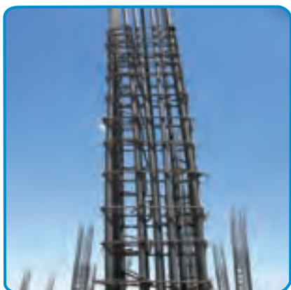
شکل ۱۹-۷- کار گذاشتن میلگردهای انتظار ستون، در فونداسیون
