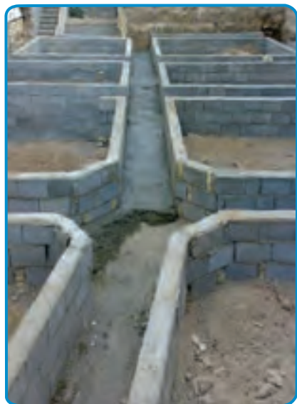
شکل ۶-۷- آماده سازی کف پی
