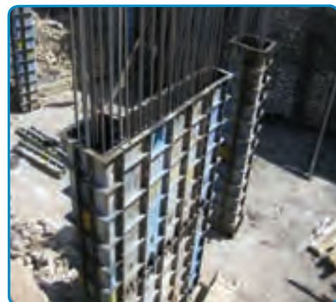
شکل ۳-۳۵- قالب فلزی برای اجرای دیوار بتنی
