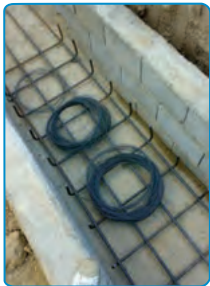
شکل ۹-۷- بهم بستن میلگردها
