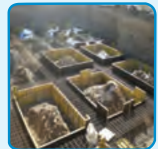
شکل ۳-۳۱- قالب فایبرگلاس برای اجرای پی
