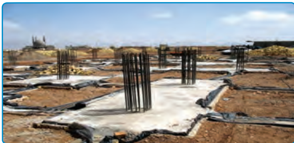
شکل ۱۰-۳- استفاده از پلاستیک در پی
