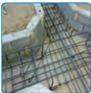
شکل ۱۳-۷- قرار دادن میلگردهای تقویتی پخها
