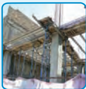
شکل ۳-۳۹- استفاده از قالب چوبی برای اجرای تیر
