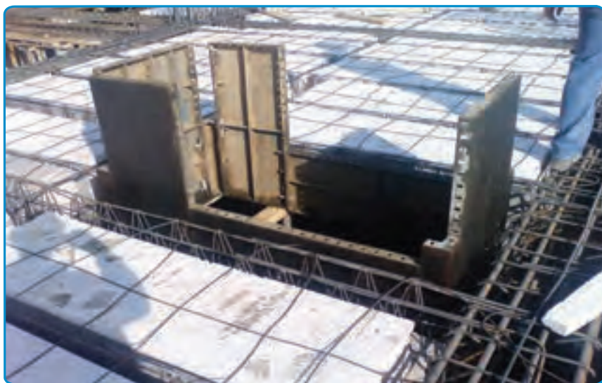
شکل ۳۵-۷- تکمیل قالب بندی
