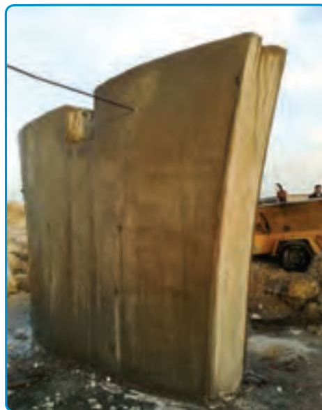
شکل ۳-۴۲- قالب برداری
