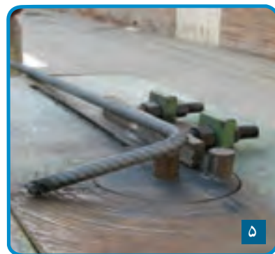
شکل ۳-۶۴- خم کردن میلگرد
