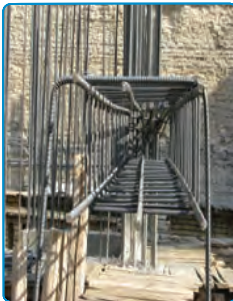
شکل ۳-۴۵- میلگرد طولی در تیر
