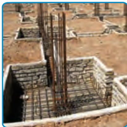
شکل ۴-۷- اجرای میلگردهای ریشه‌انتظار
