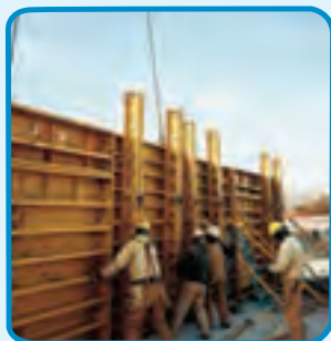
شکل ۳-۳۶- قالب فایبر گلاس برای اجرای دیوار بتنی
