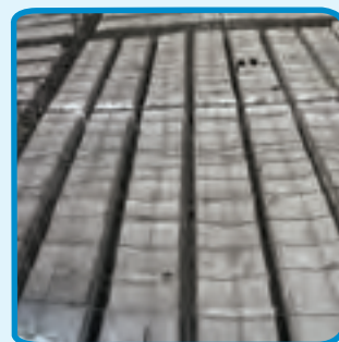
شکل ۲-۲۸- سقف تیرچه و بلوک
