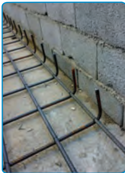
شکل ۱۰-۷- رعایت پوشش بتن در کف و بدنه
