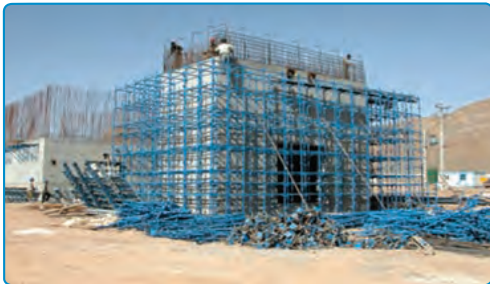
شکل ۳-۲۶- داربست فلزی
