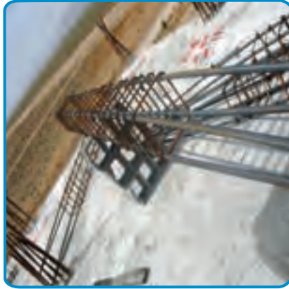
شکل ۷-۲۲- آماده کردن میلگردهای تیر روی زمین
