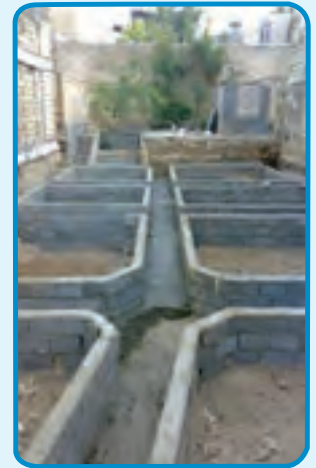
شکل ۳-۳۰- اجرای قالب پی با استفاده از بلوک بتنی
