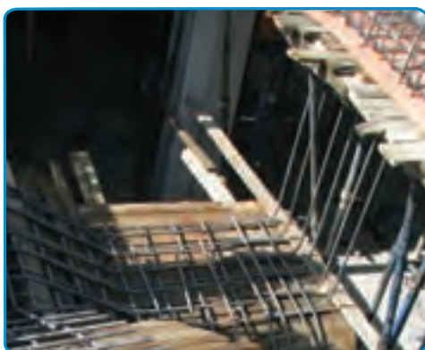
شکل ۴۱-۷- اجرای میلگردهای دال پله
