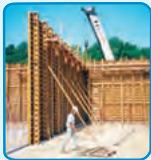
شکل ۱۹-۳- فایبر گلاس برای اجرای دیوار بتنی
