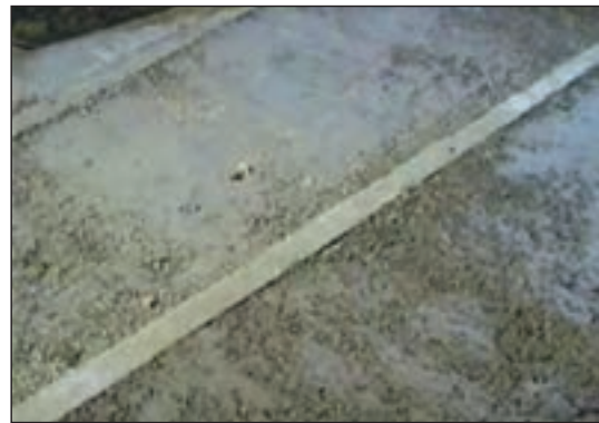
شکل ۲۱-۶ پرکردن فضای بین کرم‌ها با پوکمه معدنی
