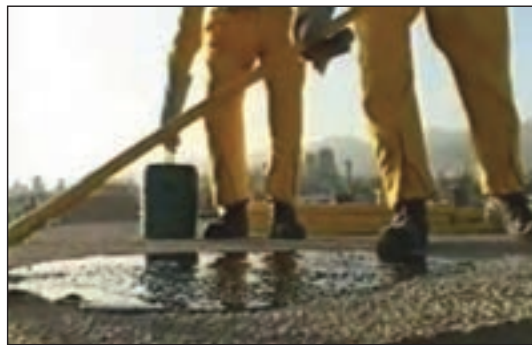
شکل ۲۲-۶ قیرگونی پس از پرکردن بین کُرْم‌ها
