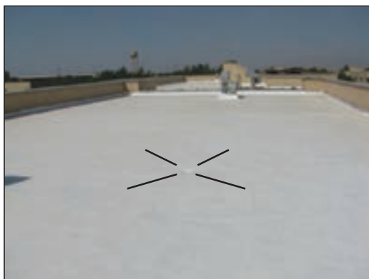
شکل ۱۱-۶ سطح پشت بام
