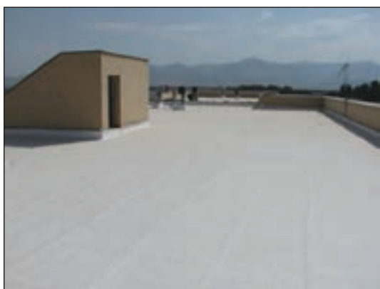
شکل ۱۲-۶ سطح پشت بام
