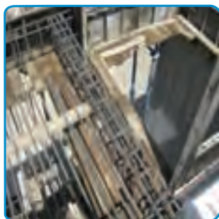
شکل ۳۱-۷-اجرای بازشودر سقف
