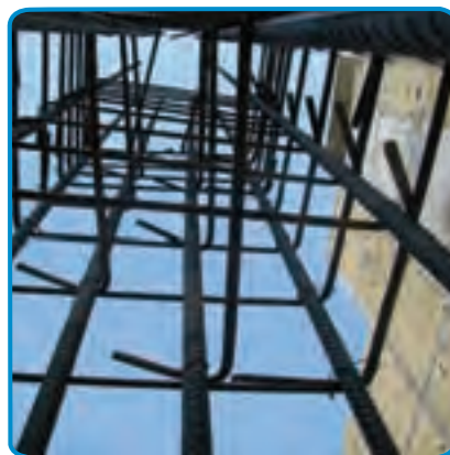
شکل ۱۹-۷- کار گذاشتن میلگردهای انتظار ستون، در فونداسیون
