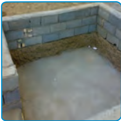
شکل ۱-۷- آماده سازی کف پی
