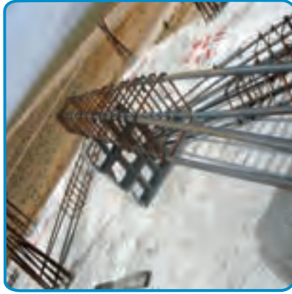
شکل ۷-۲۲- آماده کردن میلگردهای تیر روی زمین
