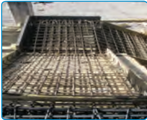
شکل ۳۷-۷- اجرای میلگردهای دال پله
