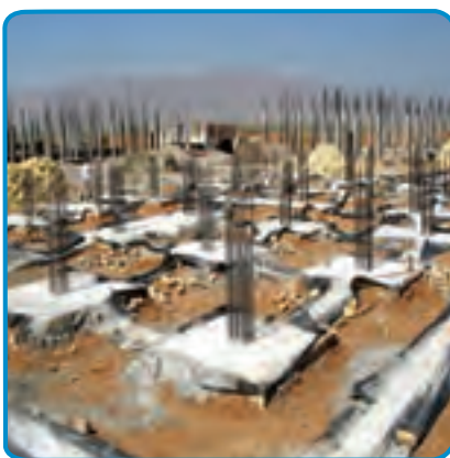
شکل ۱۷-۷- اجرای خاموت و سنجاقک
