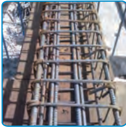
شکل ۷-۲۵- بستن خاموت ها با مفتول
