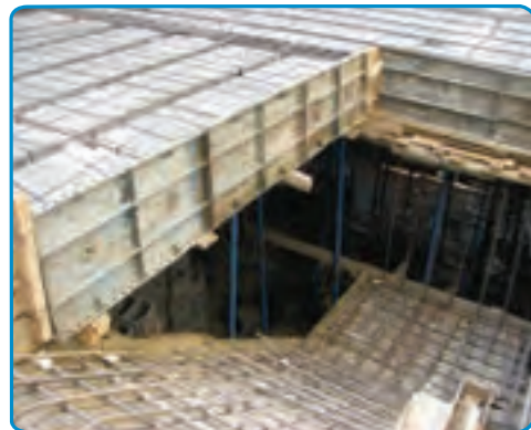
شکل ۴۰-۷- اجرای میلگردهای دال پله
