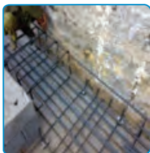
شکل ۱۲-۷- میلگردگذاری شبکه بالای
