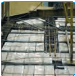
شکل ۳۲-۷-اجرای تیرهای فرعی کنسول
