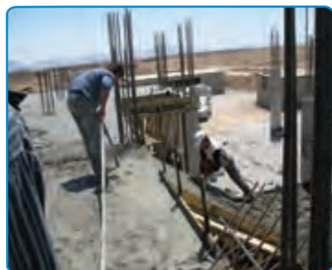
شکل ۴۲-۷- بتن ریزی دال پله
