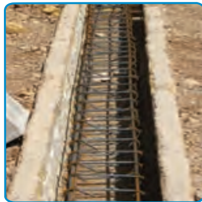
شکل ۵-۷- اجرای میلگرد شناژها
