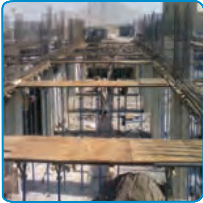
شکل ۷-۲۱- قالب بندی تیرها
