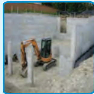
شکل ۲۱-۲- دیوار باربر
