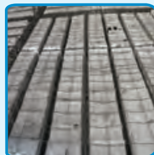
شکل ۲-۲۸- سقف تیرچه و بلوک
