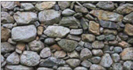
شکل ۱۳۶- دیوار سنگی خشکه چین
