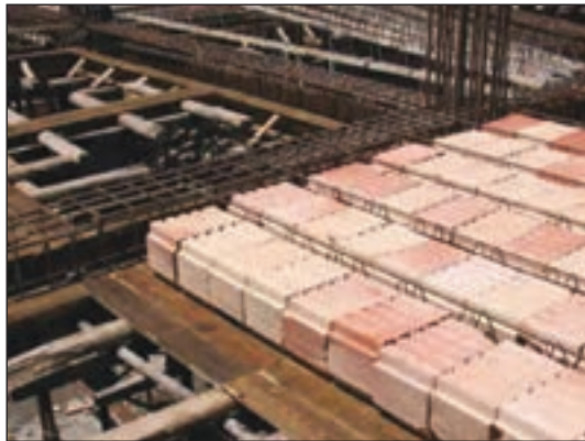
شکل ۱-۱۵۲ کاربرد بلوک سفالی در سقف
