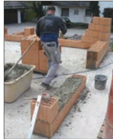
شکل ۱-۱۵۳ ساخت دیوار با بلوک سفالی
