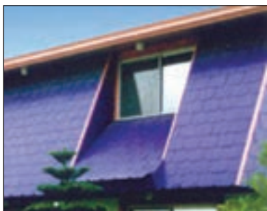
شکل ۴۷-۱ پوشش نهایی سقف شیب‌دار با آردواز
