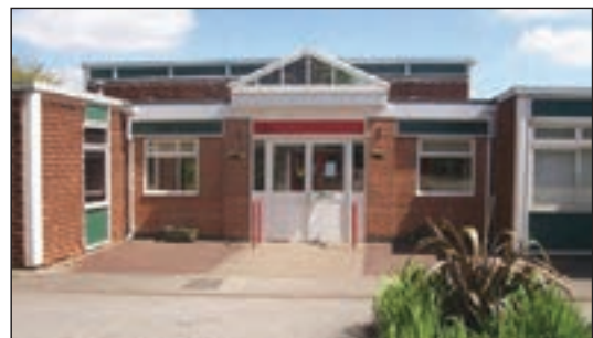
شکل ۱۳۳-۱ دیوار با نمای آجری
