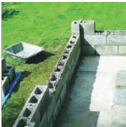
شکل ۱۵۰- ساخت دیوار با بلوک‌های بتنی یا سیمانی
