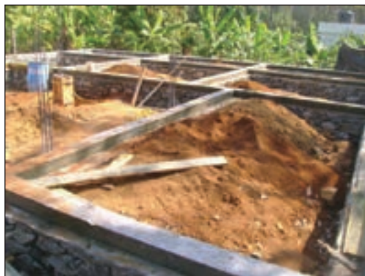
شکل ۲۰۵-۱ بتن ریزی کلاف بندی افقی تحتانی
