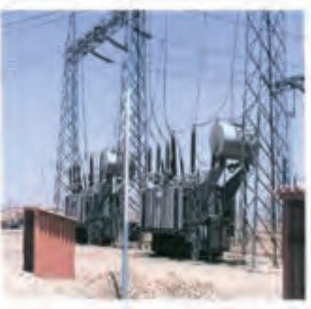
شکل (۲۸-۳) دو ترانسفورماتور موازی شده
