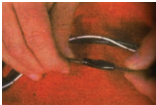
شکل ۶-۶۵- قرار دادن تیوپ عایق روی محل اتصال سیم‌ها
