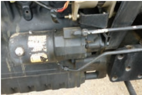
شکل ۱۴-۳- لوله‌های پمپ فرمان
