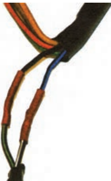
شکل ۶-۶۷- اتصال کامل سیم‌ها با روکش تیوپ عایق
