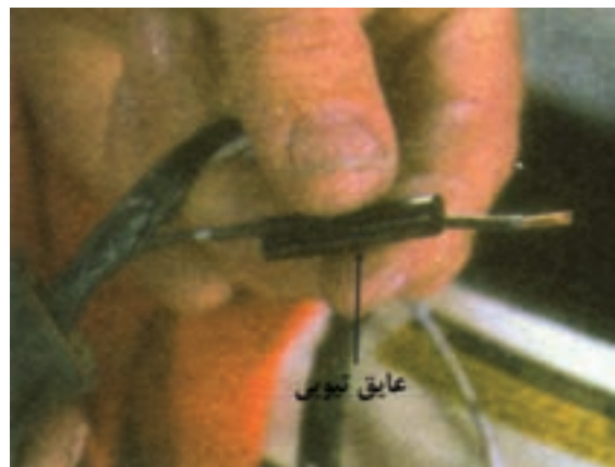
شکل ۶۳-۶- وارد کردن سیم به داخل عایق تیوبی
