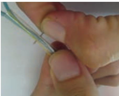
ت- عبور مفتول از لوله و ما بین دو رشته کش
