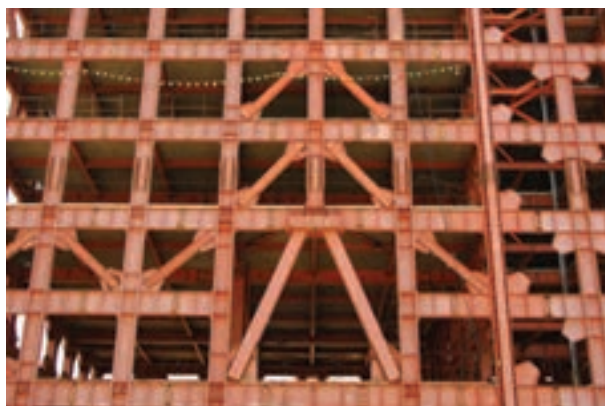
شکل ۱-۱- ساختمان با سازه اسکلت فولادی
