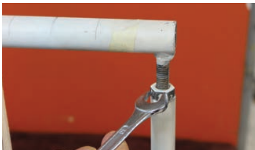
▲ تصویر ۲۹-۲ | سفت کردن مجدد پیچ های سر دار
