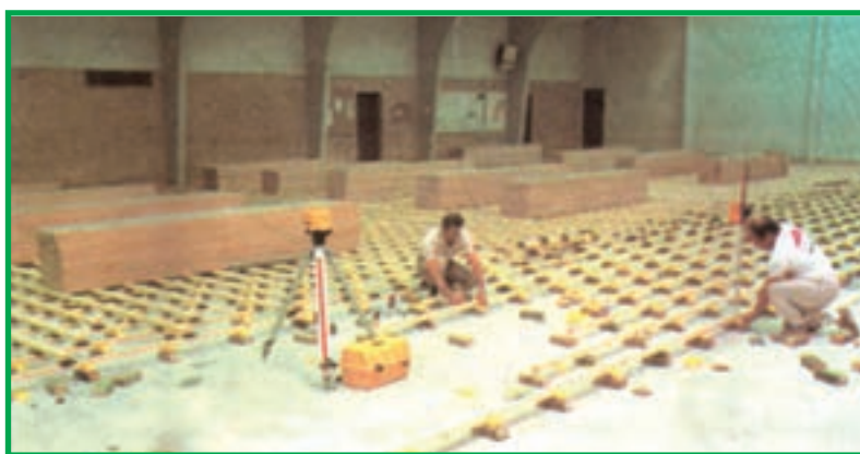
شکل ۳-۵- طریقه زیرسازی جهت نصب پارکت
