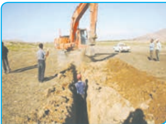
کندن زمین با بیل مکانیکی
