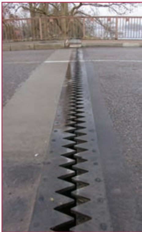
شکل ۲-۲۳- فاصله دندانانه‌ای شکل بین دو قسمت پل
