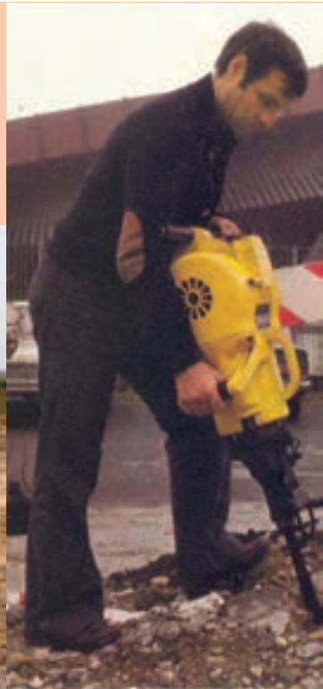
شکل ۱۴-۵- نحوه حفر ترانشه به کمک چکش مکانیکی سیار
