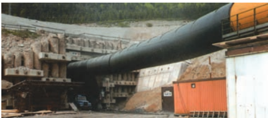
شکل ۱۳-۹- آویز جهت نصب لوله‌های تهویه
