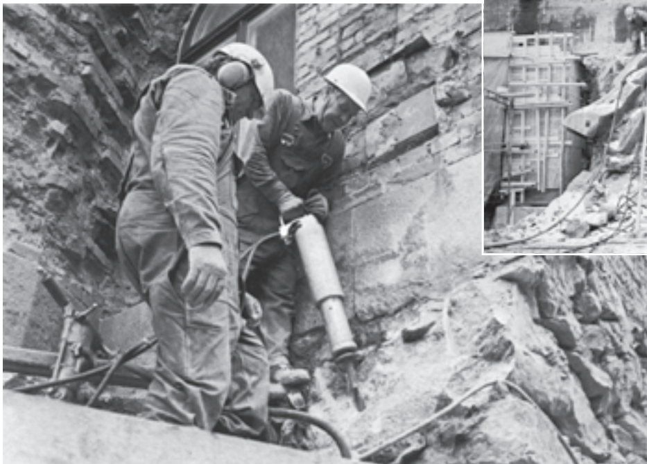
شکل ۱۵-۲- نحوه خرد کردن سنگ‌هایی که به صورت قطعات درشت بر روی هم ریخته‌اند.
