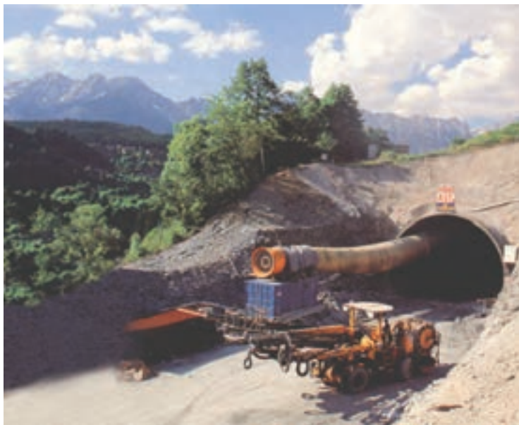
۱۴-۹- لوله‌های فلزی تهویه با اتصال جوشکاری شده
