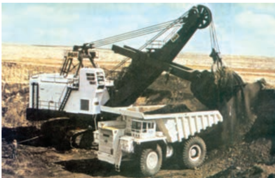
شکل ۲۴-۴- بیل کابلی در حال کار
