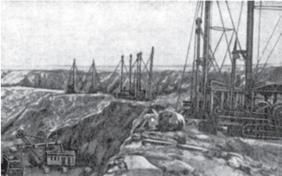
شکل ۴۵-۴- استقرار برج حفاری در امتداد پله‌های حفاری
