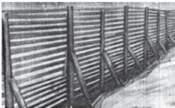
الف - دیواره بلند دائمی برای حفاظت در مقابل برف
