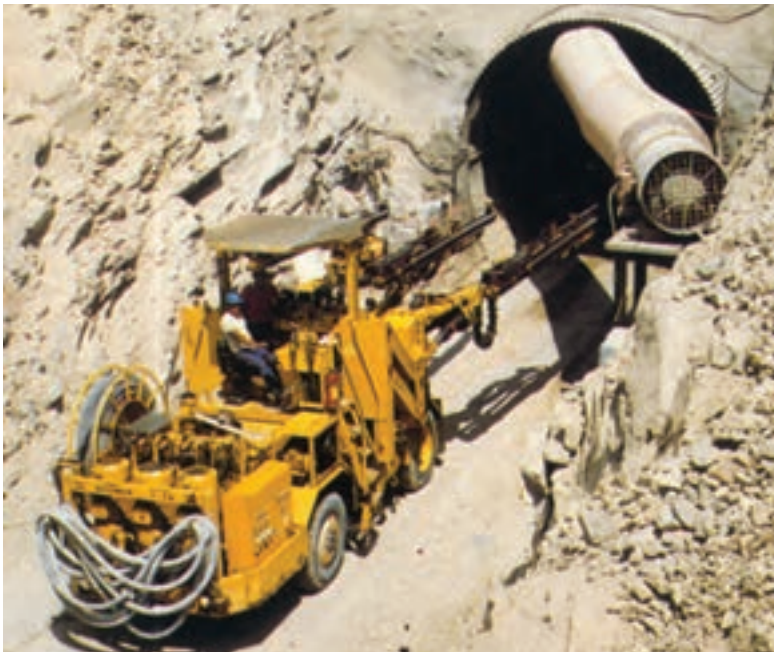
شکل ۵-۶- تونل اصلی ورودی یک معدن
