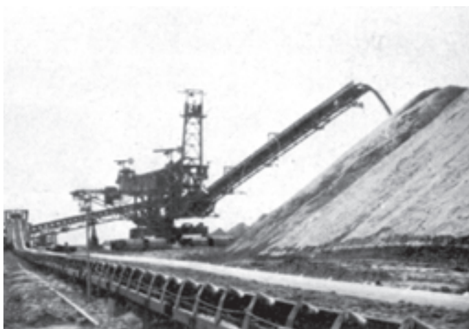
شکل ۳۱-۲ جابه‌جایی باطله توسط نوار نقاله
