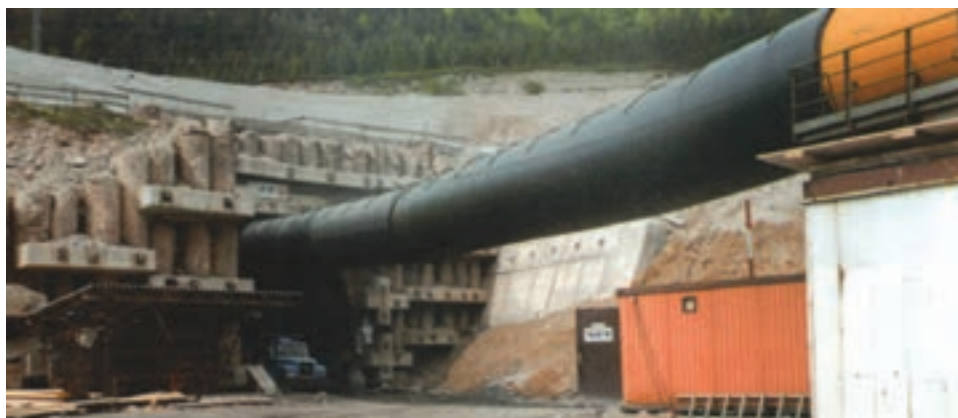
شکل ۳۶-۲- لوله‌های فلزی تهویه با اتصالات جوشکاری شده
