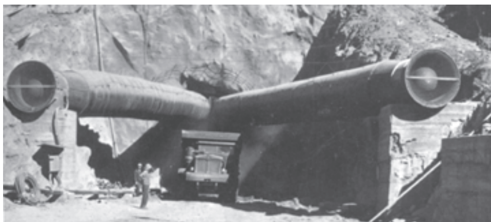
شکل ۳۷-۲- لوله‌های فلزی تهویه با اتصالات جوشکاری شده
