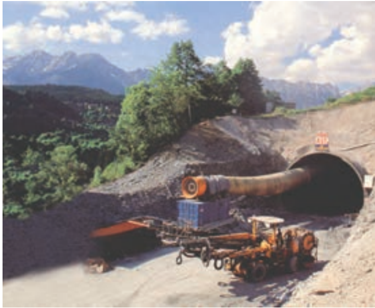
۱۴-۹- لوله‌های فلزی تهویه با اتصال جوشکاری شده
