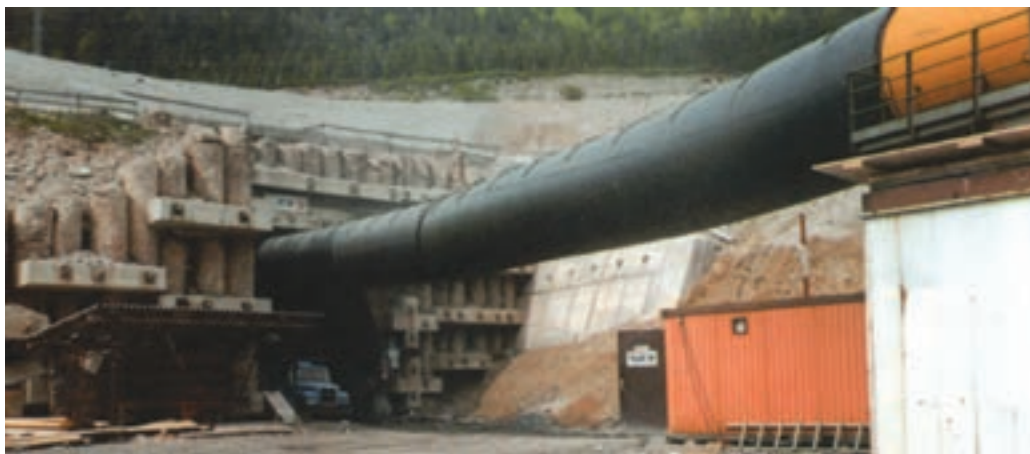
شکل ۱۳-۹- آویز جهت نصب لوله‌های تهویه
