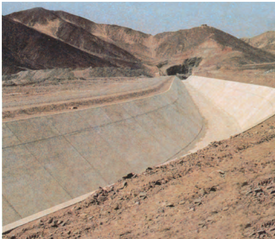
شکل ۳۱-۵ - مقطع دوزنقه‌ای در معادن روباز
