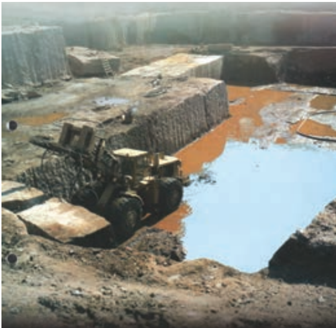
شکل ۲۶-۵- تجمع آب در معدن روباز
