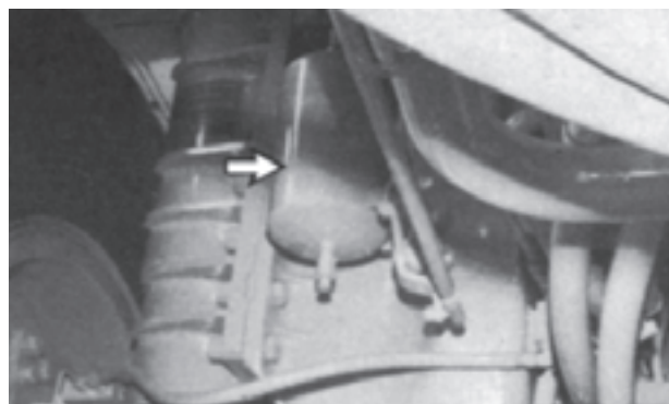
شکل ۴۰-۶- تخلیه آب و رسوبات موجود در مخزن رطوبت
