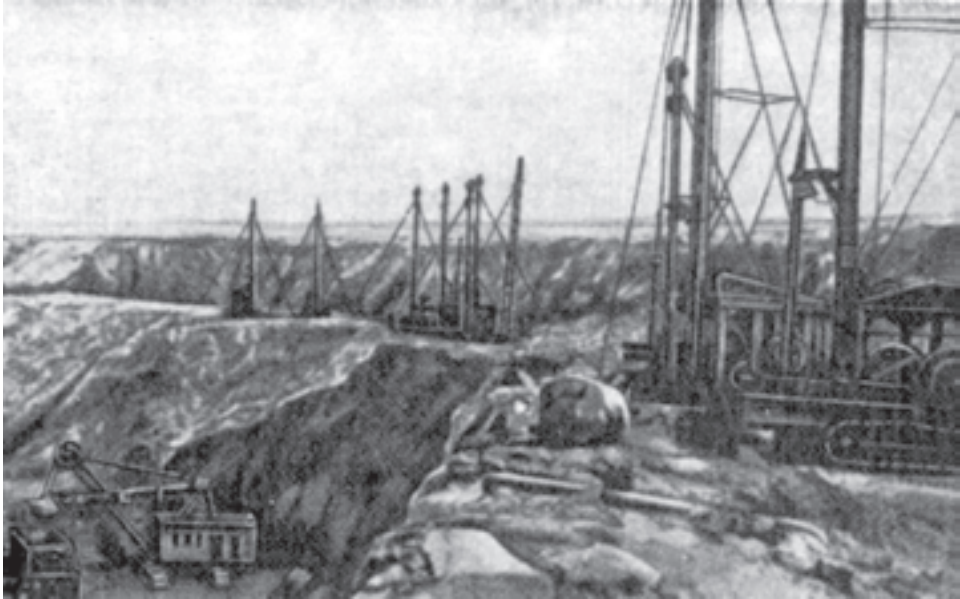
شکل ۴۵-۴- استقرار برج حفاری در امتداد پله‌های حفاری
