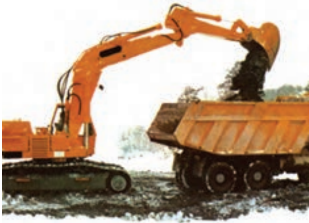
شکل ۲۳-۴- کج بیل در حال حفر کانال
