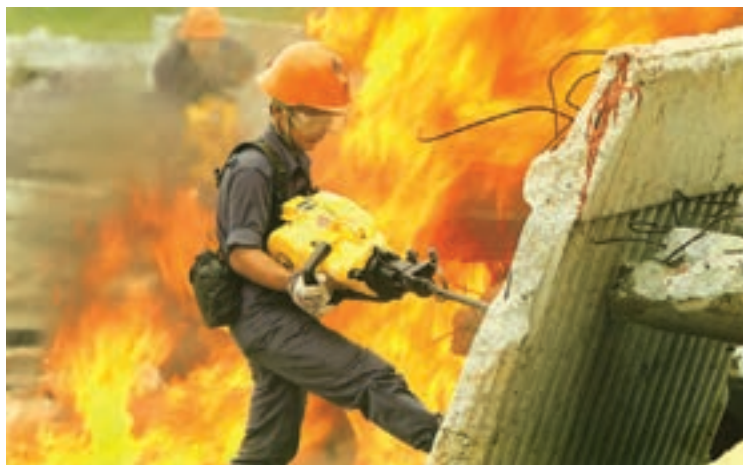
شکل ۷-۱- خرد کردن بتون
