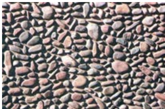
شکل ۲-۷. نماسازی با سنگ قلوه ای رودخانه ای ▲
