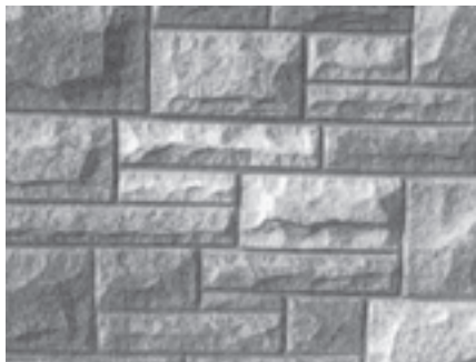
شکل ۲-۱۱. دیوار با سنگ چندوجهی سرتراش رجدار ▲
