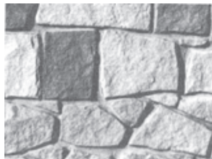
شکل ۲-۱۲. دیواره سنگ بادبر سرتراش گونیا شده به رج برده شده ▲
