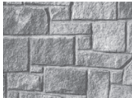
شکل ۲-۱۰. دیوار با سنگ تراش مرتب و بدون رج ▲
