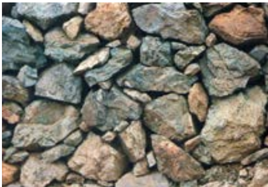
شکل ۲-۹. نمای دیوار لاشه چینی شده بدون ملات ▲
