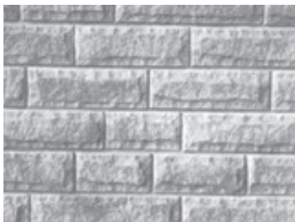
شکل ۲-۱۳. دیوار با سنگ بادبر مرتب و با رج‌های مساوی ▲
