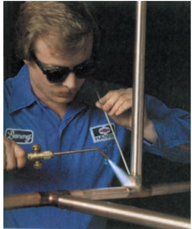
شکل ۵-۱- روش اجرای بریزینگ
