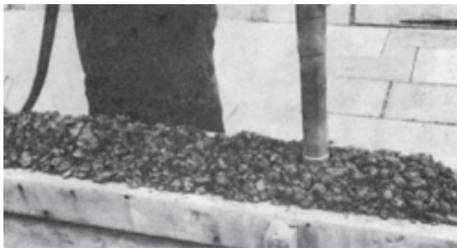
شکل ۱۲-۶- فرو بردن یک لرزانده‌ی میله‌ای در داخل بتن تازه در یک قالب تیر
