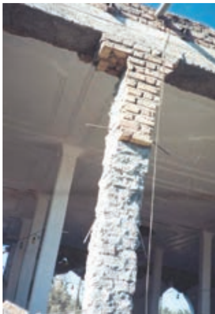
فاصله‌ی زیاد شناژهای قائم و عدم پیوستگی دیوار با آن‌ها موجب فرو ریختن دیوار شده است.
