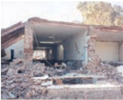
عدم اجرای شناژ قائم و افقی در مدارس قدیمی، موجب تخریب آن‌ها در اثر زلزله شده است.
