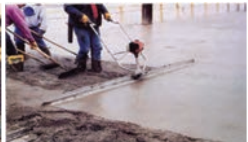
شکل ۶-۲۵- استفاده از شمشه‌های دارای ویبره برای تراز کردن و متراکم نمودن سطح، به صورت همزمان
