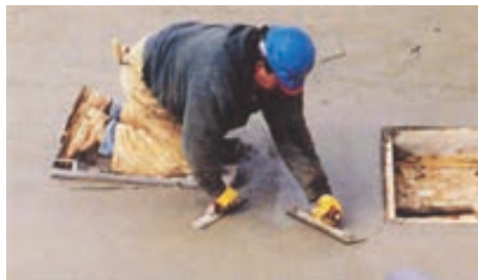
شکل ۶-۲۸- پرداخت نهایی با ابزار دستی
