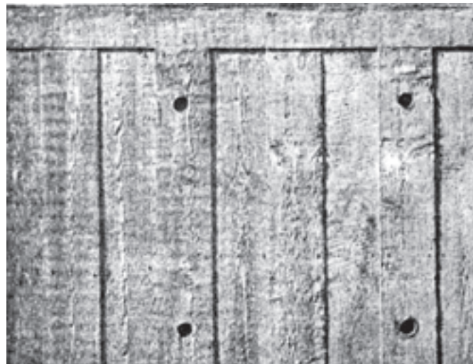
شکل ۶-۳۴- نمونه‌ای از محل‌های مهاری پر نشده
