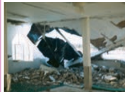
عدم اجرای صحیح شناژهای قائم در ساختمان نیمه‌اسکلت مسجد موجب تخریب ساختمان آن شده است.
