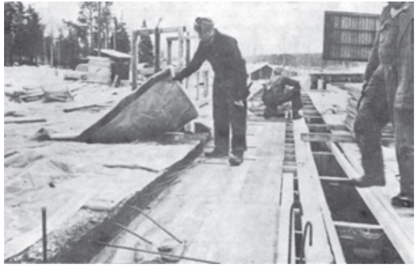
شکل ۳۰-۳۱- روکش‌های عایق ساخته شده با الیاف معدنی در ورقه‌های پلاستیک برای محافظت دال
