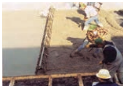
شکل ۶-۲۵- استفاده از شمشه‌های دارای ویبره برای تراز کردن و متراکم نمودن سطح، به صورت همزمان
