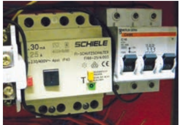
شکل ۲۱-۱- فیوز حفاظتی نصب شده در کارگاه
