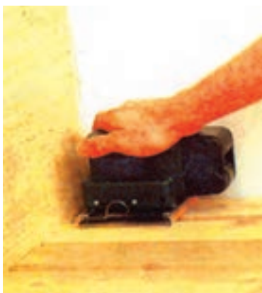
شکل ۲۱-۱۲- سنباده زدن گوشه‌های کار با سنباده لرنزی
