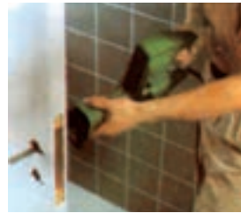
شکل ۲-۱۳- برش جای قفل با اَره افقی چکشی
