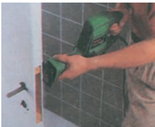
شکل ۲-۵۶- سوهان‌کاری جا قفل درب چوبی به وسیله‌ی اره‌ی همه کاره
