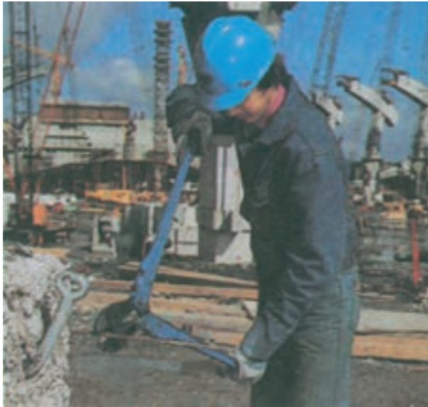
شکل ۱۲-۵۲- نحوه‌ی کاربرد سیم‌چین بزرگ
