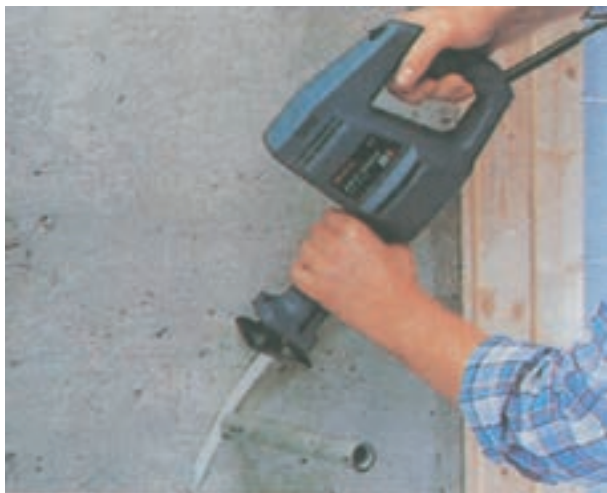
شکل ۲-۵۷- استفاده از اره‌ی همه‌کاره جهت قطع اضافات مصالح هم سطح قطعه‌ی کار
