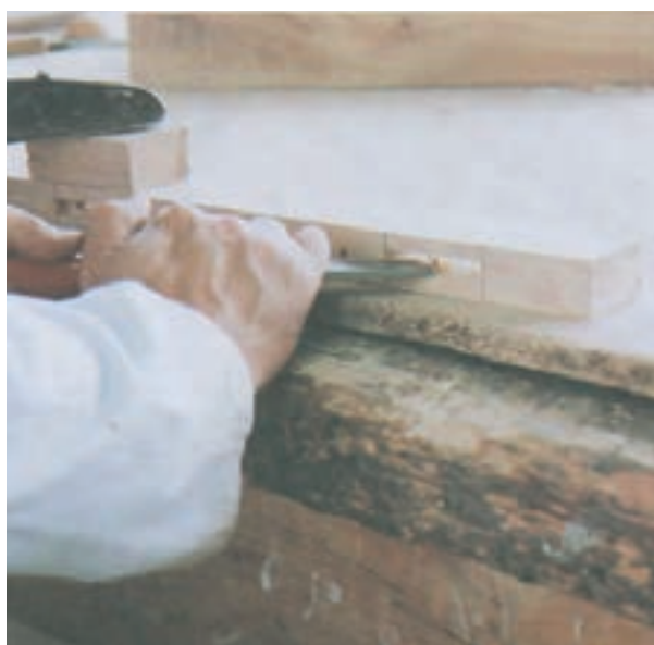
شکل ۱۳-۶ نحوه‌ی خالی کردن کُم با مغار
