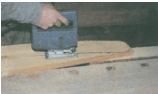
شکل ۳۵-۱۴- خط شابلون در قسمت بریده شده به قطعه اصلی دیده می شود.
