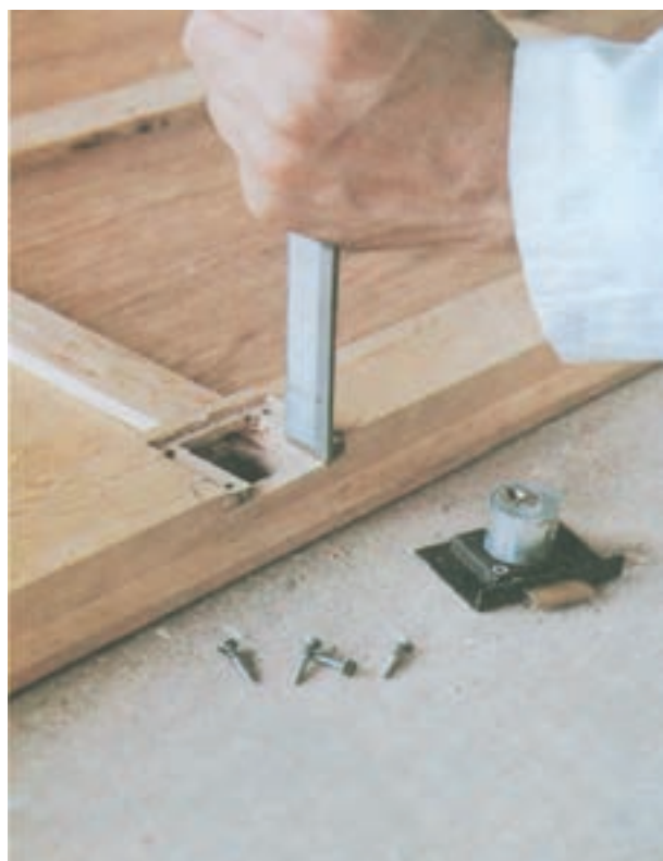
شکل ۱۵-۶ استفاده مغار برای در آوردن جای قفل
