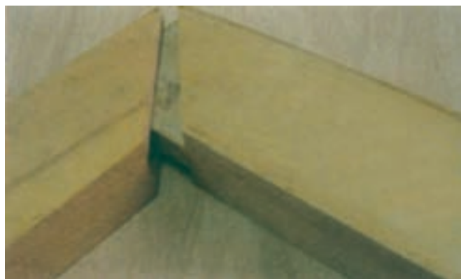
شکل ۸۹-۱۴- اتصال کام و زبانه
