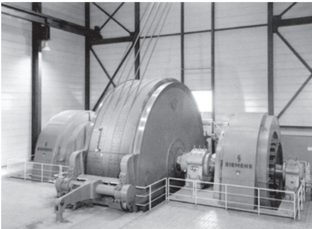
شکل ۱۳-۱۴ - ساختمان مخصوص جرثقیل [۱۳]
