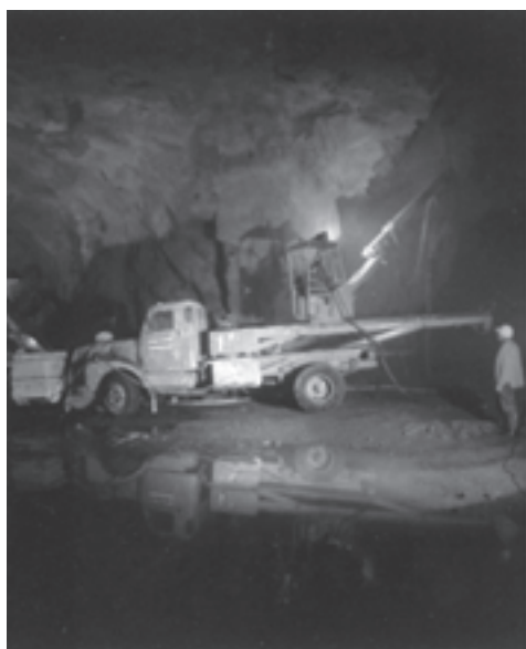
شکل ۷-۳۲- ایجاد یک لایه بتن با سیستم شاتکریت
