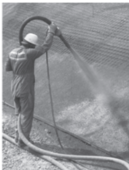
شکل ۷-۳۲- ایجاد یک لایه بتن با سیستم شاتکریت
