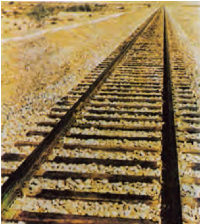
شکل ۱-۶- تراورس راه آهن اشباع‌شده با کروتوزوت
