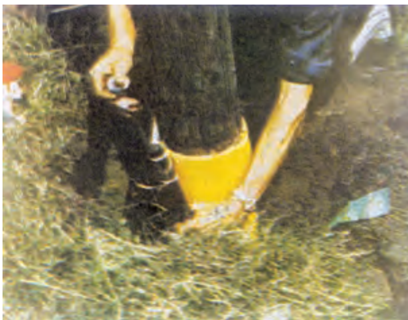
شکل ۱۱-۶- روش بانداژ کردن برای تیرهای نصب‌شده کهنه
