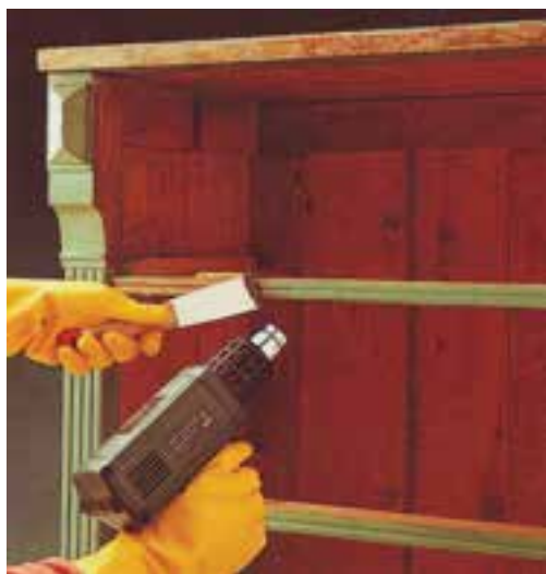
شکل ۱۷-۱۱ برداشتن رنگ از سطح کار به کمک سشوار صنعتی با گرم کردن رنگ.
