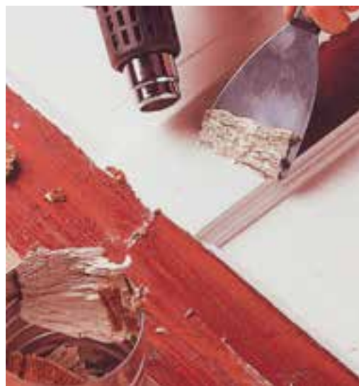
شکل ۱۱-۱۲- برداشتن رنگ به روش حرارتی.
