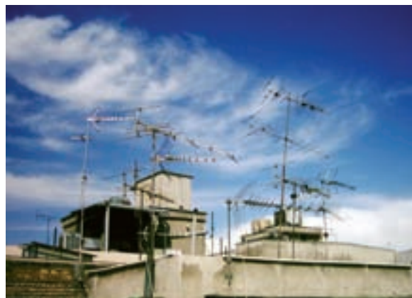
شکل ۷-۲۹ — یک مجتمع مسکونی با چندین آنتن در کنار هم
