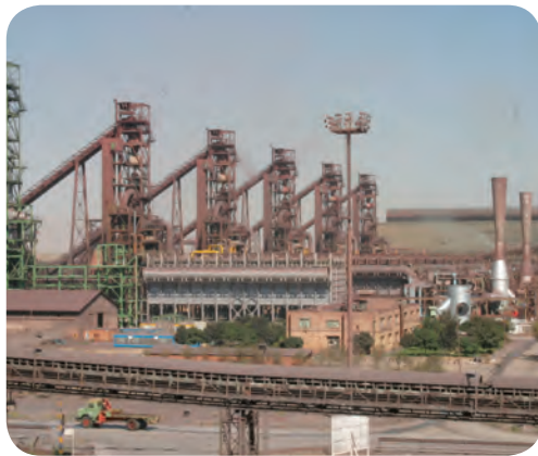
تأسیسات احیاء سنگ آهن به روش مستقیم در مجتمع فولاد مبارکه اصفهان
