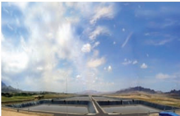
شکل ۱۶-۵- تصفیه‌خانه فاضلاب شهر بیرجند
